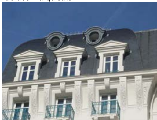
Toiture à la Mansart en ardoise, l'Impérial
