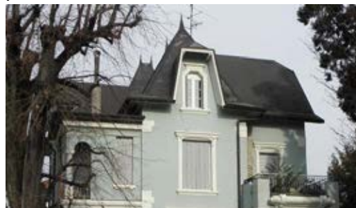
Toiture complexe en ardoise
