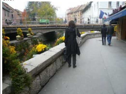
Garde-corps en pierre
