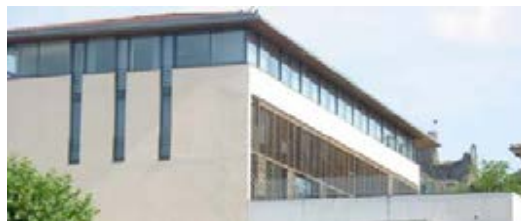
Institution Saint Charles à Vienne, toiture simple à versants avec rive de toit traitée sobrement.
