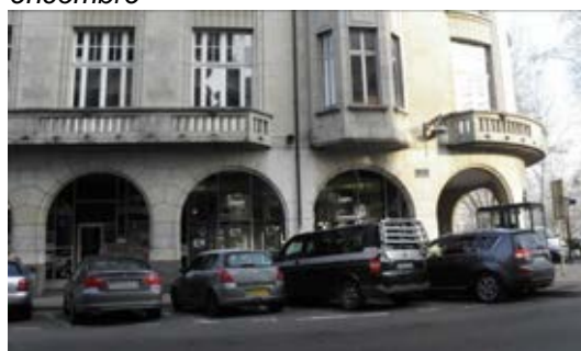
Stationnement en épi envahissant qui perturbe la perception des arcades et entrave la traversée de la rue pour les piétons.
