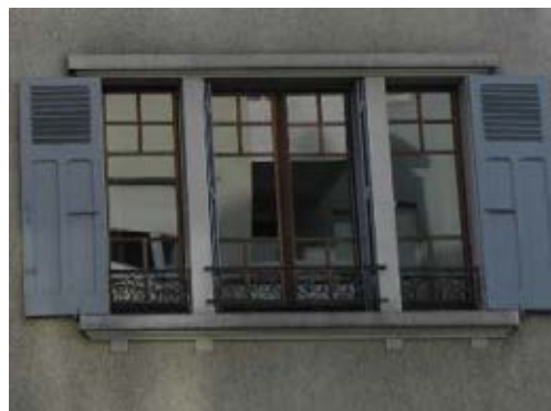
finesse de partition du vitrage à conserver
