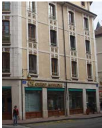
Ici le rez de chaussée commercial suit bien la composition de la façade.
