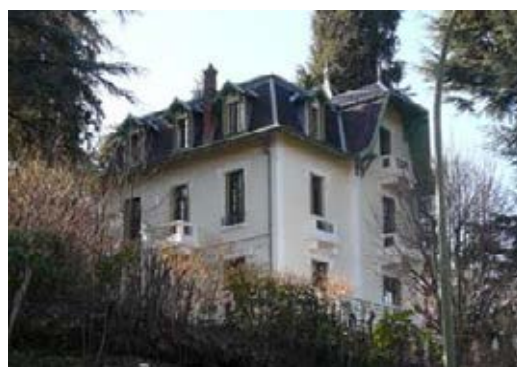
Toiture à la Mansart en ardoise, villa
