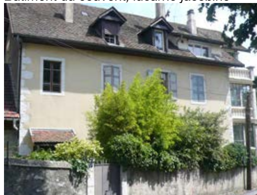
La grande lucarne double à droite dénature le toit. Chemin de la Tour
