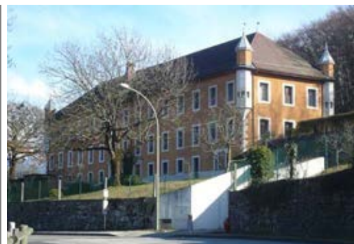
L'évêché, bâtiment intéressant
