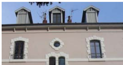
Fines lucarnes positionnées dans l'axe des ouvertures de la façade.
