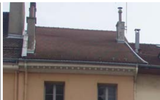
Passées de toit avec corniches moulurées Rue Notre Dame
