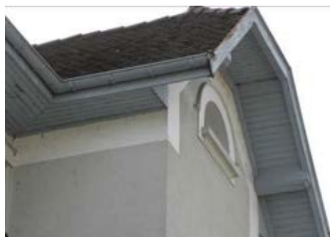
Passée de toit peinte dans les tons de la façade
