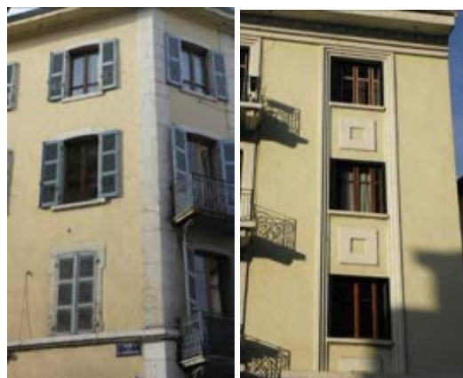
Exemples d'enduits lissés bien réalisés, venant buter contre les encadrements et les chaines d'angle (XIX o et XX o s.)
