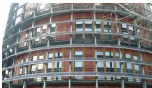
Exemple de conception architecturale intégrant les panneaux solaires en façade. Alixan (Drôme)
