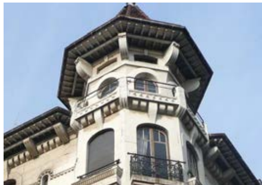
Passée de toit remarquable
