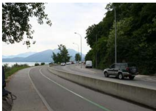
Le caractère routier de la rue des Marquisats et de la RN508 (emprise, glissières béton, vitesse des véhicules) qui longent la promenade
