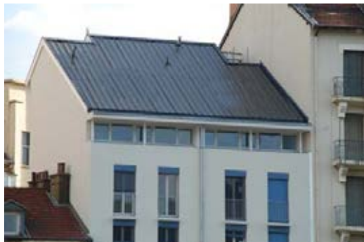
Grenoble. Retrait de l'attique pour créer un balcon et un étage entièrement vitré.
