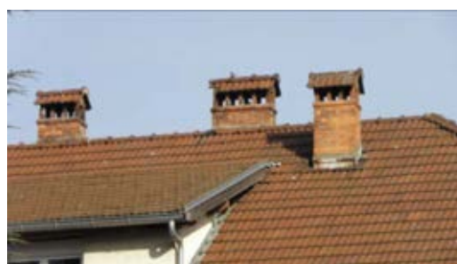
exemple de conduits de cheminée en briques à conserver à l'identique
