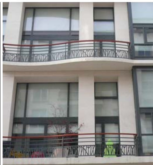
Détail des ouvertures immeuble rue de la Poste
