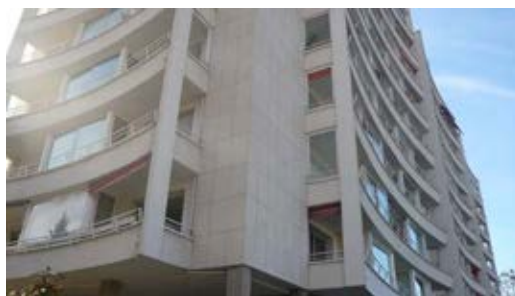
Immeuble avenue de Trésum
