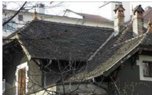
couvertures en tuile écaille, les souches sont en brique, présence de coyau, passée de toit importante, bandes de rives étroites.
