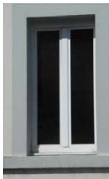
interdit: Menuiserie plastique et montants épais: ici la surface pleine (cadre + ouvrant) est presque aussi importante que celle du vitrage Le vitrage plein jour banalise la façade.
