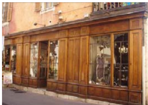
Très bel ensemble de vitrine posé en applique, à conserver
