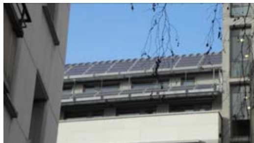
Rue de la Paix. Panneaux en toiture
