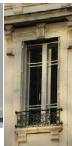
Une bonne solution comme ici consiste à poser un deuxième châssis à l'intérieur de l'habitation, ce qui permet de conserver intacte la menuiserie d'origine.
