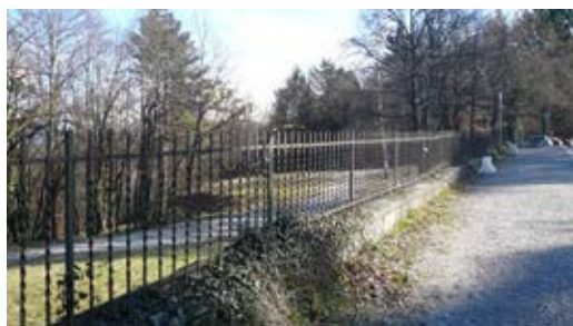
Clôture du parc des Marquisats, exemple de clôture à conserver
