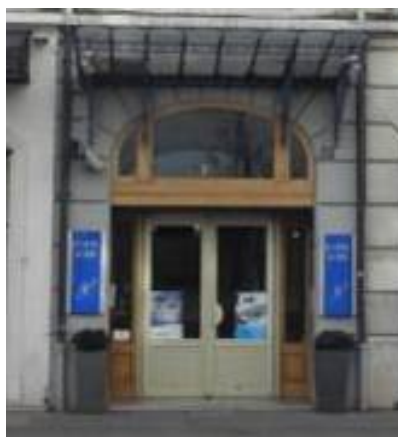
Changement partiel de l'entrée : aucune cohérence avec la partie conservée ni avec le style de l'immeuble.
