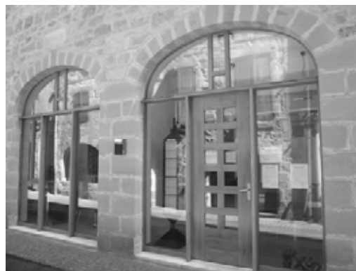
Figeac ; Bureaux du service urbanisme
