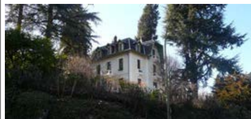
Villa Boulevard de la Corniche, bâtiment intéressant.
