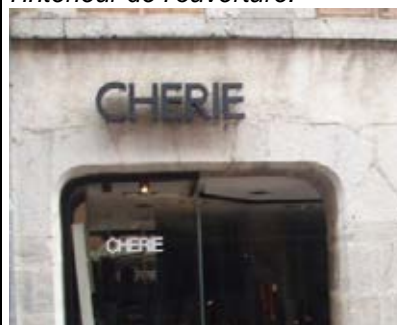
Enseigne positionnée à l'extérieur de l'ouverture. Lettres en métal découpé fixées sur la maçonnerie
