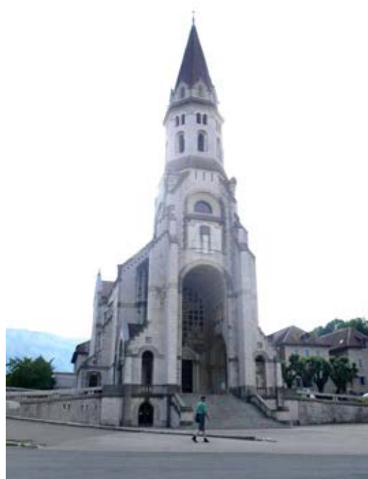
Aujourd'hui c'est un immense espace goudronné prévu pour le stationnement des cars, peu agréable pour le piéton.
