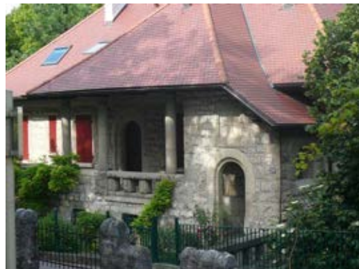
Toiture en tuiles écaille, avenue de la Visitation
