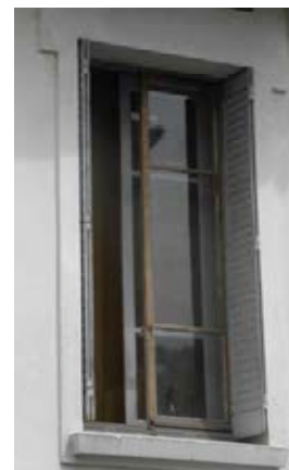
Une bonne solution comme ici consiste à poser un deuxième châssis à l'intérieur de l'habitation, ce qui permet de conserver intacte la belle menuiserie d'origine.
