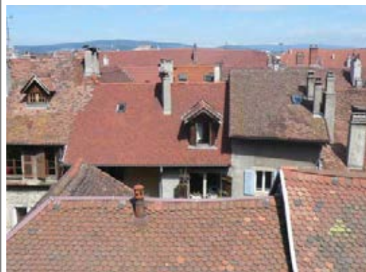
La vue plongeante depuis les pentes du château sur les toitures de la vieille ville impose d'être vigilant pour la cinquième façade des constructions. Dans un souci de conserver un ensemble de toitures très homogène, les règles imposent des toitures traditionnelles à versants, couvertes de tuiles.
