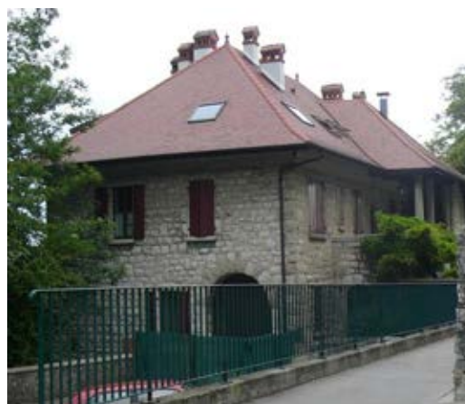
Fenêtres de toit discrètes
